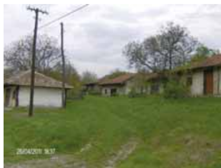
Foto 38 Pivnice – locuri de depozitare a vinului
